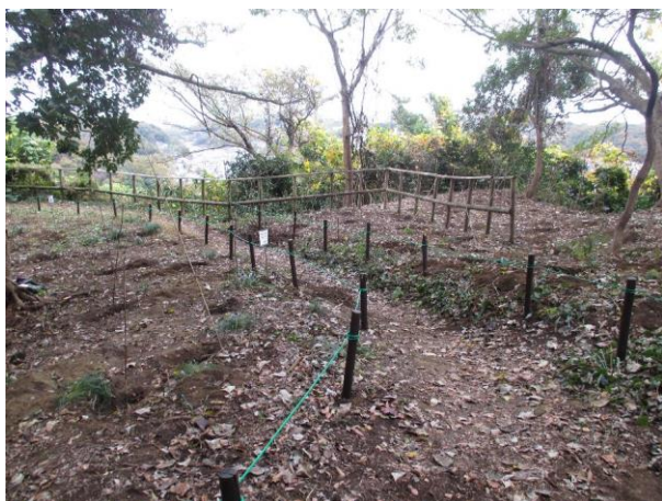
杭打ちと整地
